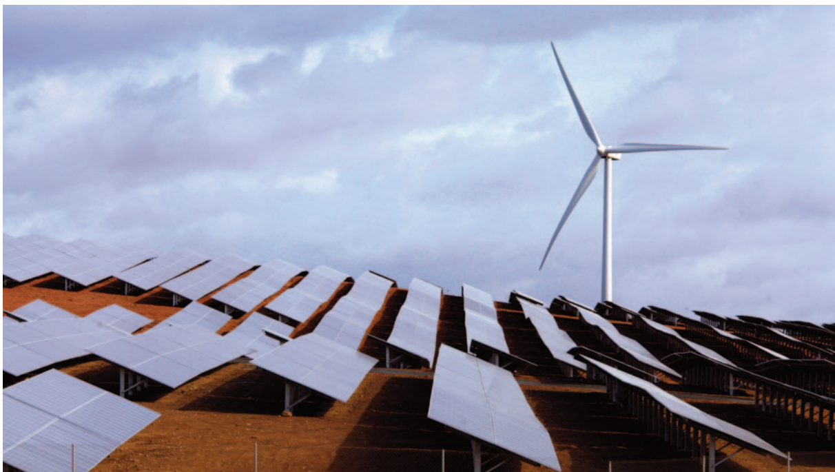
50 MW hybrid plant, El Andévalo, Spain.
